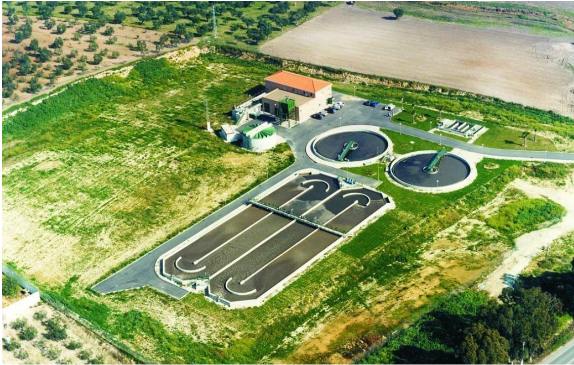
EDAR de Utrera. Font: Junta d'Andalusia
